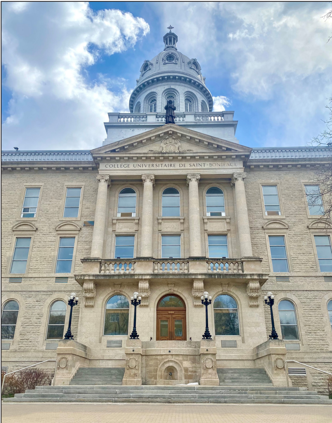
Université de Saint-Boniface, St. Boniface College, 200 Avenue de la Cathédrale, portion of front façade, 2021. (City of Winnipeg)
